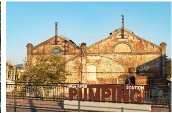
遠賀川水源地ポンプ室
