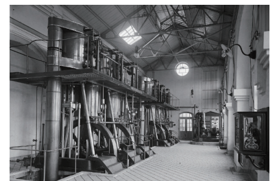
建設当時は、工業用水の安定送水に世界的実績のあるデビー社製蒸気ポンプを導入。
