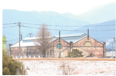
雪景色のポンプ室。季節に関係なく、製鐵所の鋼材生産に必要な工業用水の約6割を送水。
