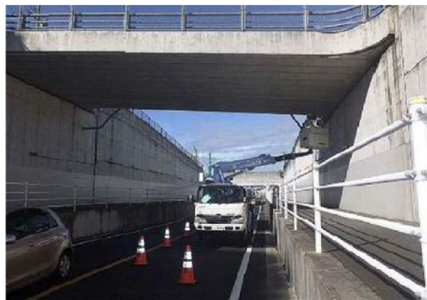
〔高所作業車による定期点検状況〕
