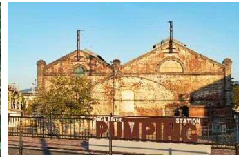
遠賀川水源地ポンプ室
