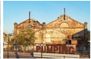
遠賀川水源地ポンプ室
