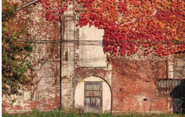
↑大村係長撮影。10ページのポンプ室写真も係長撮影
