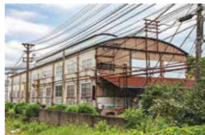
旧鍛冶工場 製鐵所の建設に必要な鍛造品を製造するために建てられた。
