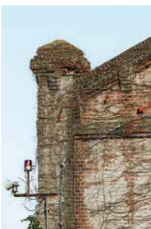
↑灰白色の鋳造煉瓦。赤煉瓦よりも吸音性に優れています。
