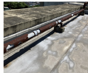
屋上設備配管の老朽化
