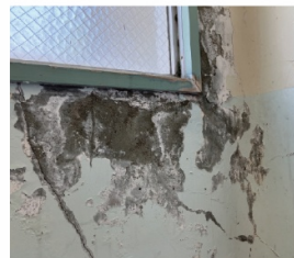
階段室壁のひび割れ
