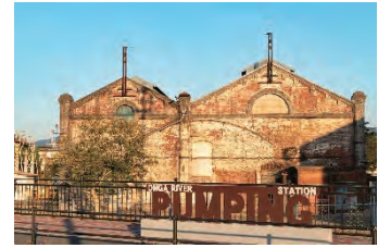
遠賀川水源地ポンプ室
