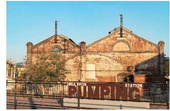
遠賀川水源地ポンプ室
