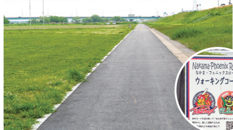
↑市役所前の河川敷から中間大橋付近まで、全長約2kmの遊歩道を整備。従来より幅が広がり、より歩きやすくなりました。
