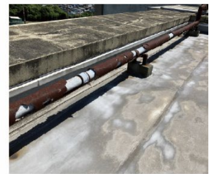
屋上設備配管の老朽化
