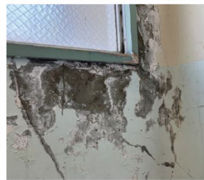
階段室壁のひび割れ
