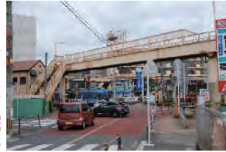
昭和56年に設置された通谷横断歩道橋
