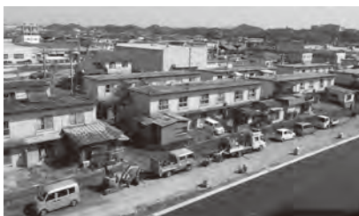
中鶴地区市営住宅 （3棟目）の建設予定地
