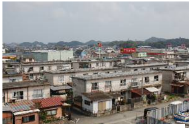
中鶴更新住宅2期新築工事 予定地
