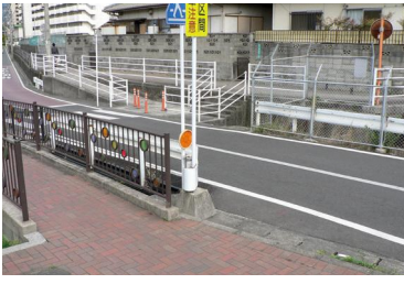
補修の完了した朝霧水路18号線
