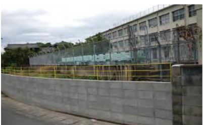
修繕後の底井野小学校ブロック塀
