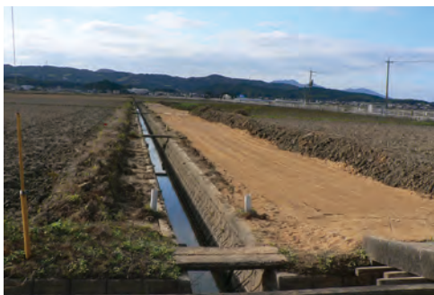
農道整備工事（寺田水路）
