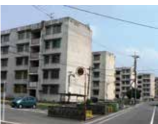
中鶴の県営住宅
