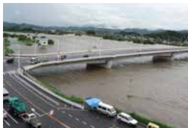
雨で増水した遠賀川
