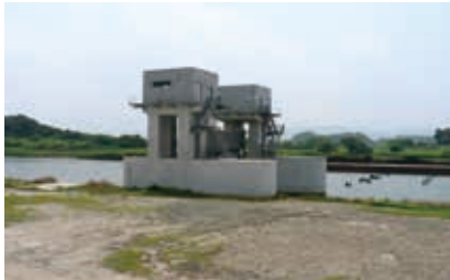
中間堰改修工事
