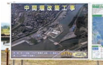
中間堰改修工事
