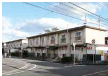
中鶴地区の市営住宅
