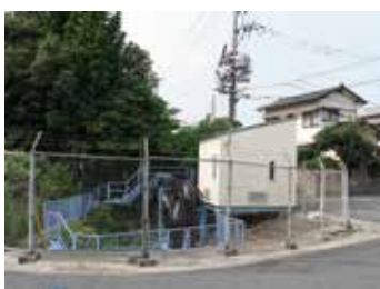
出原ポンプ場
