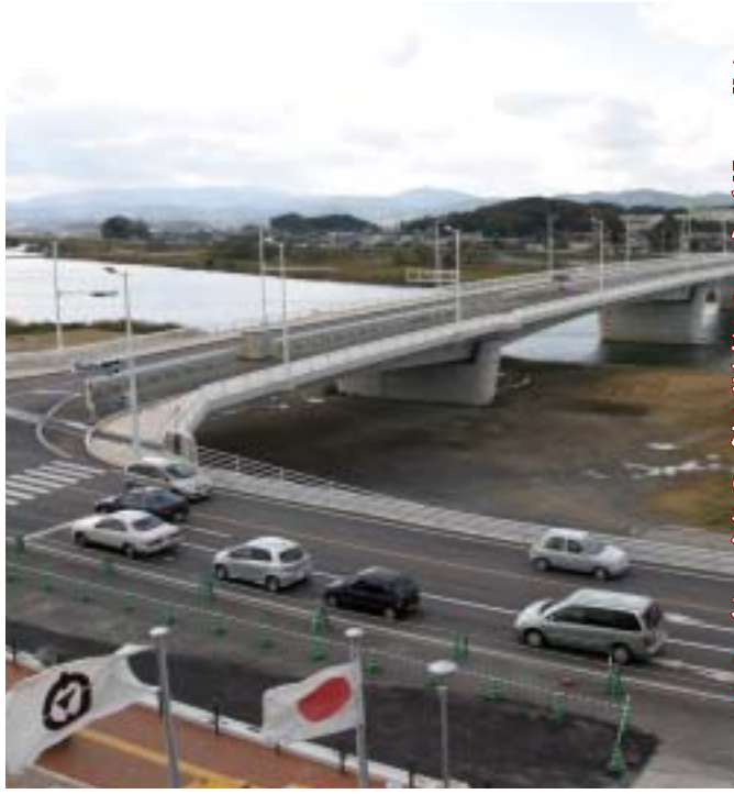
平成18年1月21日全面開通予定の遠賀橋
