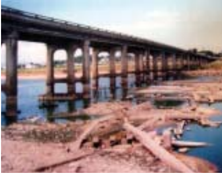
旧遠賀橋（平成6年8月撮影）
