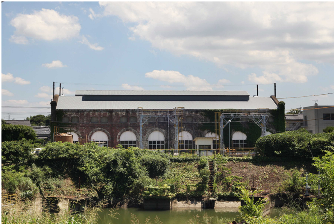
遠賀川水源地ポンプ室 沈砂池から
