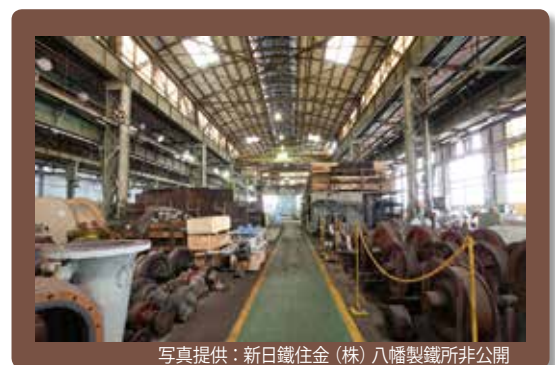
写真提供：新日鐵住金(株)八幡製鐵所非公開
