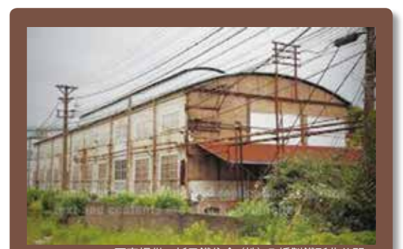
写真提供：新日鐵住金(株)八幡製鐵所非公開
