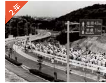
国道3号岡垣バイパス開通
