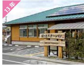
水巻町ほっとステーション新築移転
