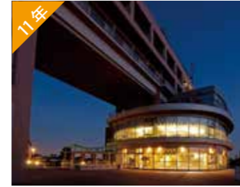
マリントラスあしやオープン
