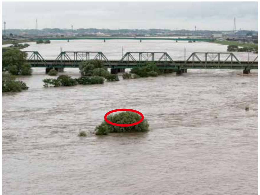
激しい大雨により市役所前の河川敷が冠水。平成22年7月、芦屋町方面に向かい市役所屋上から撮影。
