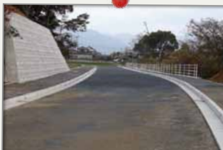
御座ノ瀬・中ノ谷線 バイパス道路工事
