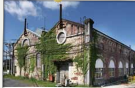
遠賀川水源地ポンプ室が 世界文化遺産推薦候補に
