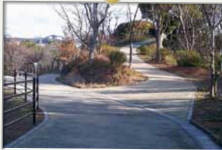
垣生公園などの大規模改修
