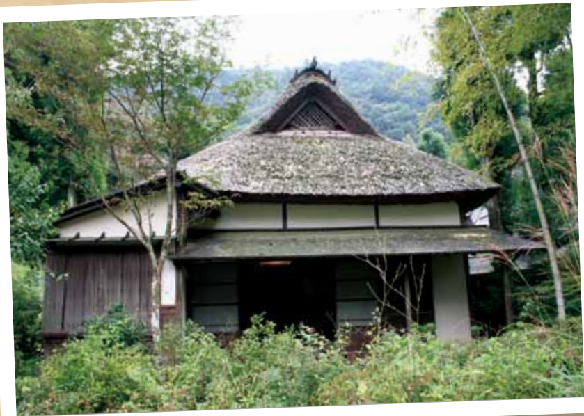
松の茶屋田舎家（箱根町） 三井財閥、有賀長文の別荘として魯堂が建築したもの
