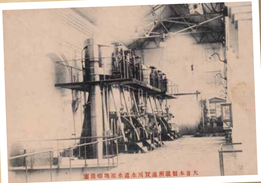
八幡製鐵所遠賀川水源池製所製日本大 八幡製鐵所遠賀川水源池製所製日本大 ※唧筒とはポンプのことです。
