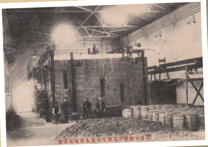
八幡製鐵所遠賀川水源地汽罐室 (絵はがき)
