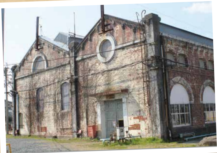
八幡製鐵所遠賀川水源地ポンプ室（灰色の柱部分が鋳滓煉瓦）
