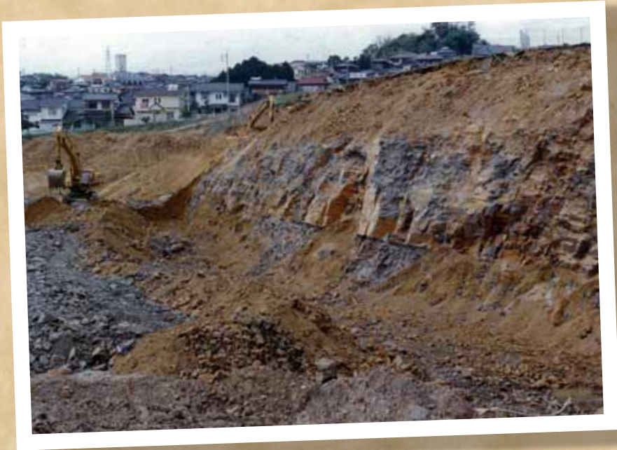
新中間病院工事の際に見られた地層
