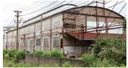
1900 (明治 33) 年、修繕工場とおなじくGHH. 社が設計、鋼材加工、仮組み立てを行ったのち、国内で建設された鉄骨建造物です。屋根はドイツ式の樽型屋根で、大型の工具などを造っていました。
