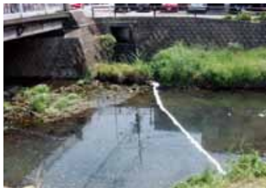
油が下流へ流出しないようにオイルフェンスを設置したときの様子(曲川切畑橋付近)
