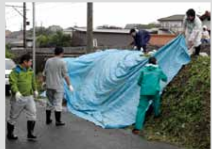
大雨により法面の一部に亀裂が入った様子。被害が拡大しないよう、職員が応急処置を施しました。
