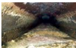
油やごみが堆積し、下水の流れが妨げられている下水道管の様子。 (上：上蓮花寺一丁目のマンホール、右：上蓮花寺一丁目の下水道管内部)
