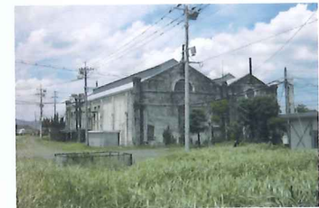
遠賀川水源地ポンプ室
