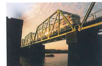
JR 筑豊本線の遠賀川鉄橋
