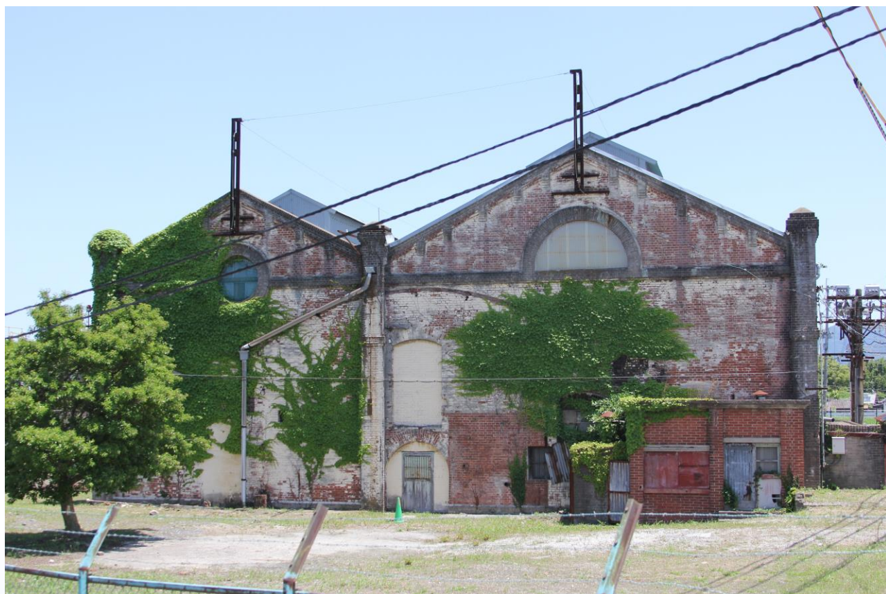
【遠賀川水源地ポンプ室】
