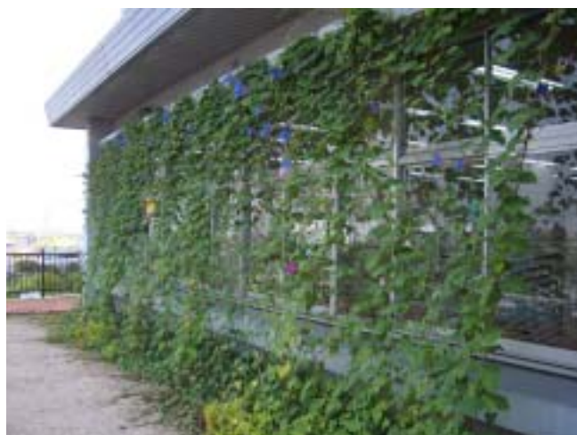
「アサガオ」を使った日よけを設置し、エアコン（冷房）の電力消費量を削減している。
