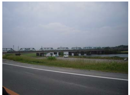
JR 筑豊本線の遠賀川鉄橋
