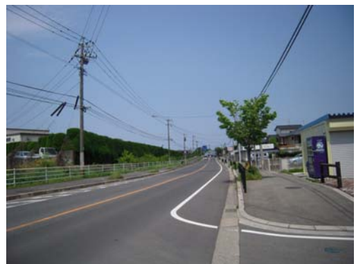
主要地方道中間・宮田線
