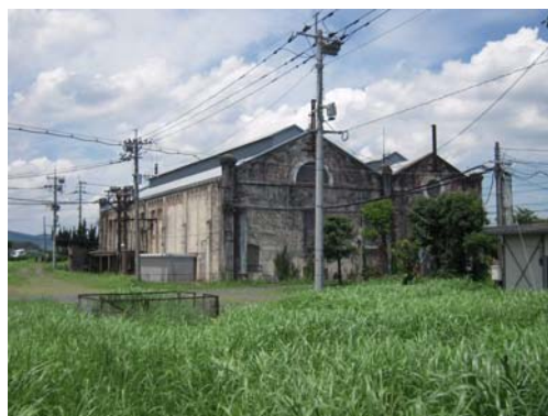
旧官営八幡製鐵所関連施設 （遠賀川水源地ポンプ室）
