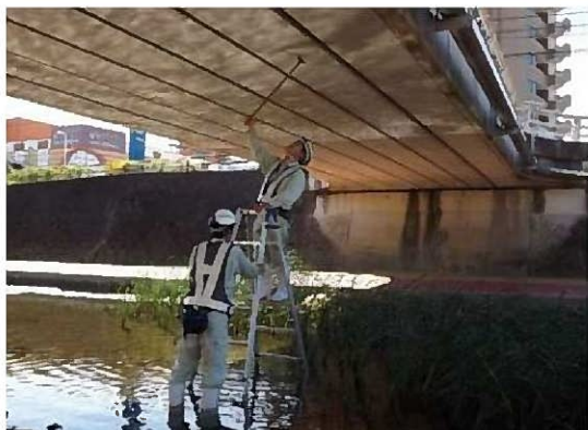
[ 梯子による定期点検状況 ]
