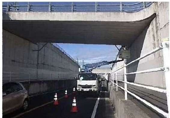
[ 高所作業車による定期点検状況 ]
