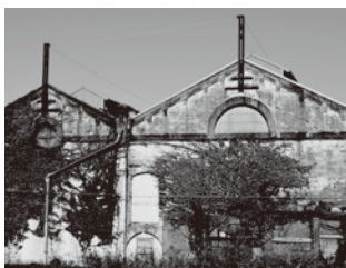
▲遠賀川水源地ポンプ室
