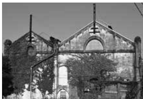
▲遠賀川水源ポンプ室
